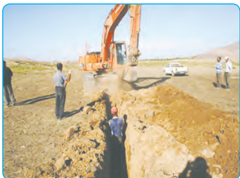
کندن زمین با بیل مکانیکی
